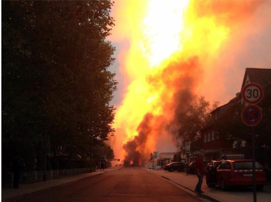
Zu dem Unglück am 23. Oktober 2014 war es gekommen, als Bauarbeiter die Pipeline zur Wartung freilegen wollten. Dabei wurde mit einem Bagger eine Spundwand in den Boden getrieben, die die Hochdruckleitung an 2 Stellen durchlöcherte.
